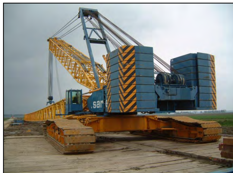
Photographie 9: Photo de la grue permettant l'assemblage des différents éléments d'une éolienne
