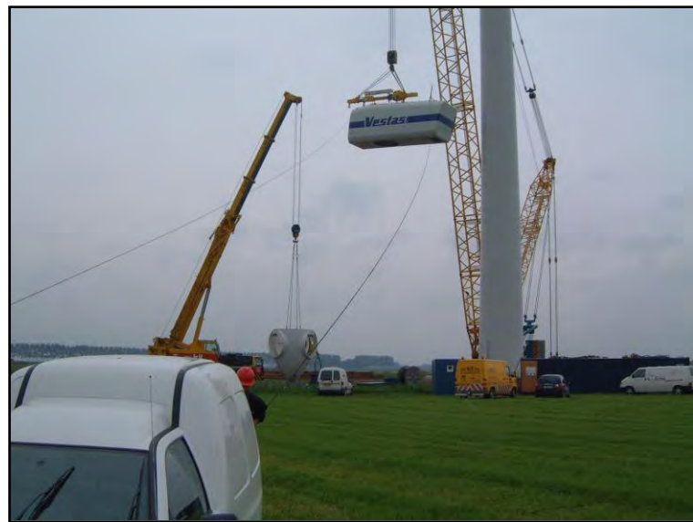
Photographie 13 : Montage de la nacelle
