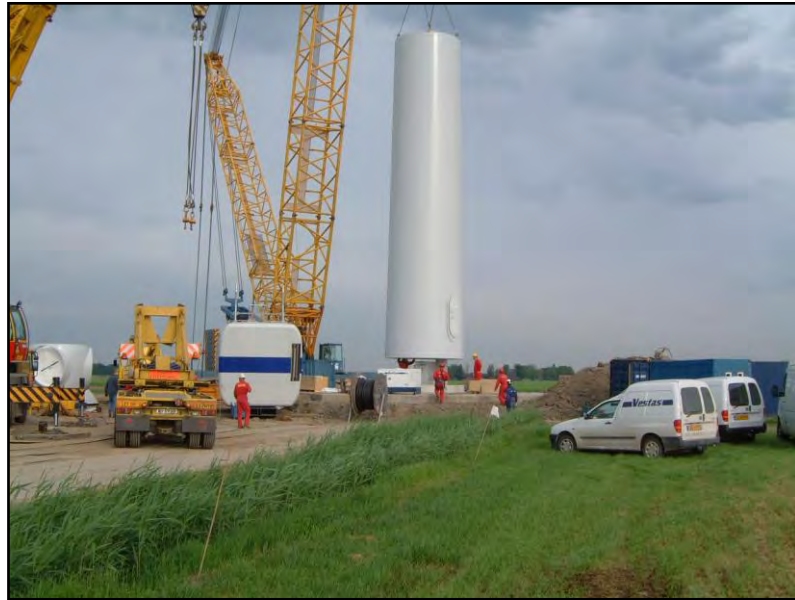
Photographie 12 : Montage de la première section du mât
