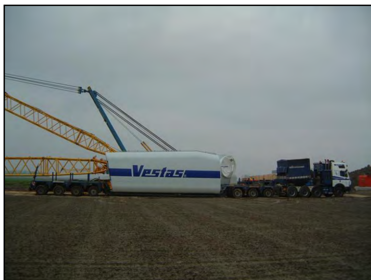
Photographie 10 : Transport de la nacelle
