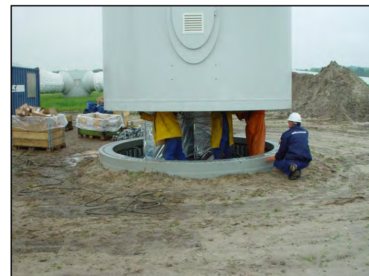
Photographie 12 : Montage du mât sur la fondation
