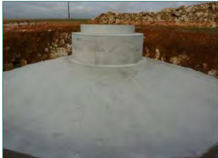
Photographie 8 : Fondation après coulage béton
