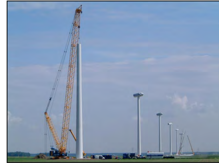
Photographie 14 : Un parc de neuf éoliennes Vestas V80 en construction
